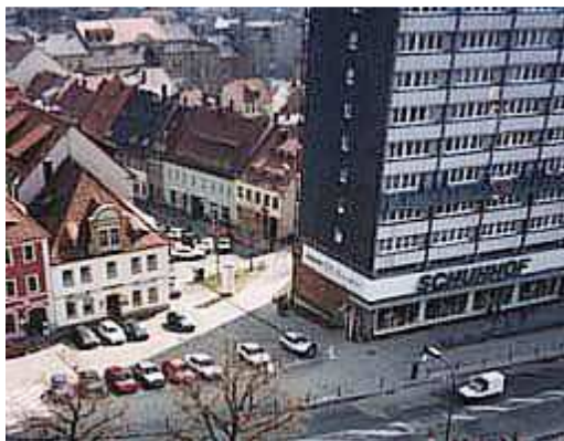
Hochhaus vor Rückbau
