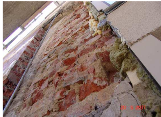
rückgebaute Wetterschale: keine Anker im MW
