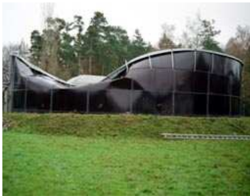
eingestürzter Güllebehälter
