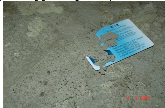
abgelöste Beschichtungen
