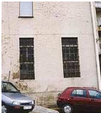
Gebäudegiebel eines Wohnhauses Aufnahmen des Bereiches EG - 1 .OG
