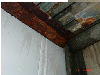
teilweise stark korrodierte Doppelparkerteile
