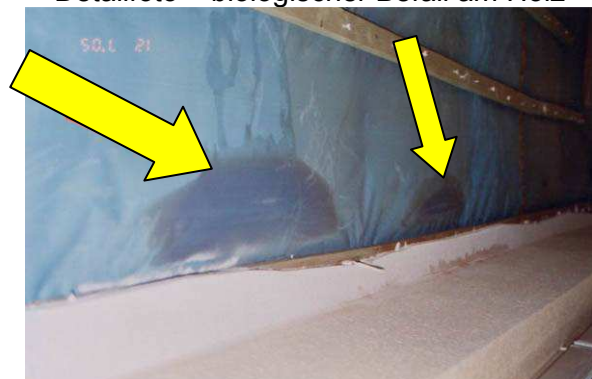
Wasseransammlungen auf der Dampfbremse
