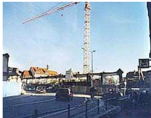
Hochhaus nach Rückbau
