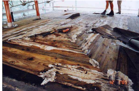
Dachoberseite nach Rückbau der Dachhaut
