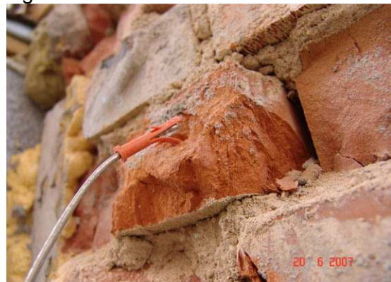
lockere Dübelanker
